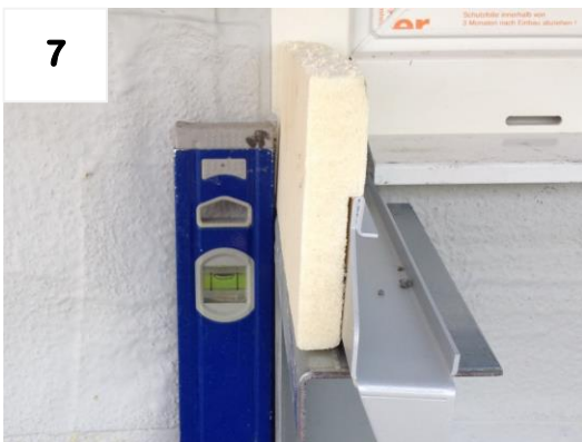
Verstärkungsbügel ausrichten
